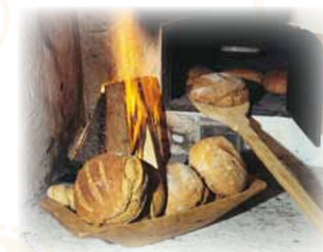
I kjelleren er det bygget en ekte, gammeldags bakerovn. Her stekes brød, kjøtt, fisk, grønnsaker, pizza og desserter. – Ovnens brukes ofte sammen med gjestene på Thorbjørnrud. Maten blir ekstra god og saftig i en bakerovn, mener Olav Lie-Nilsen. Ovnens er satt opp i samråd med Else "Sprossa" Rønnevig som har spesialisert seg på bygging og bruk av bakerovner.
