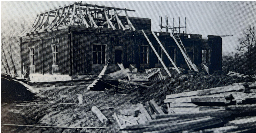
Thorbjørnrud bygges om i 1911.
